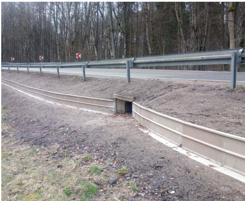
Fot. 11. Przejścia dolne dla drobnych kręgowców w Kosewie / Photo 11. Underpass passages for small vertebrates in Kosewo
