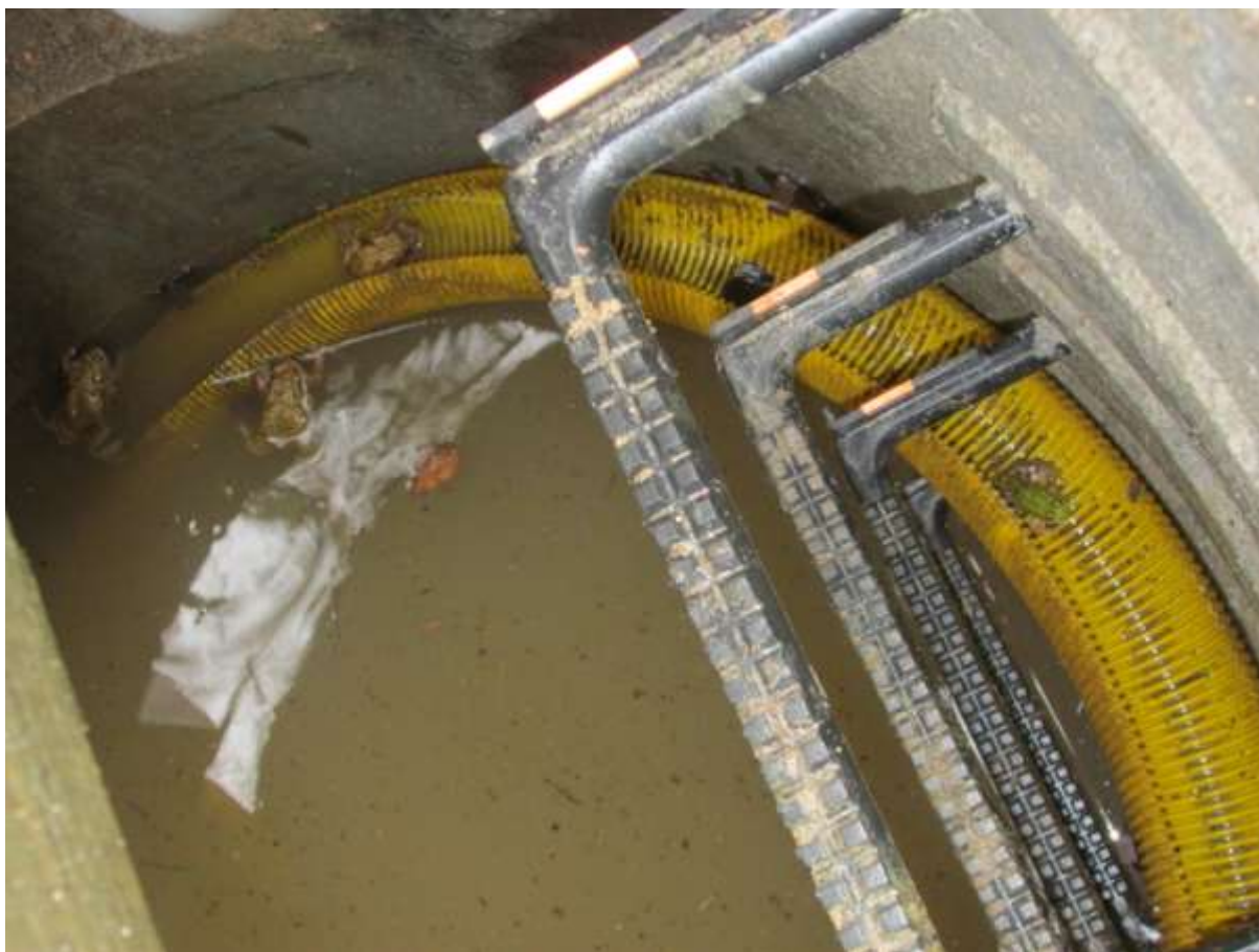
Ryc. 3. Płazy korzystające z pomostu umieszczonego w studzience
