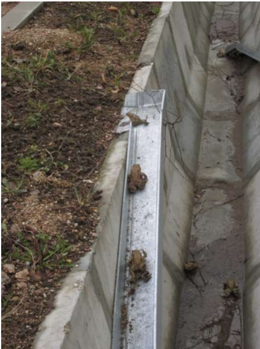
Ryc. 6. Ropucha szara opuszczająca korytko krakowskie po zainstalowanym elemencie wyjściowym
