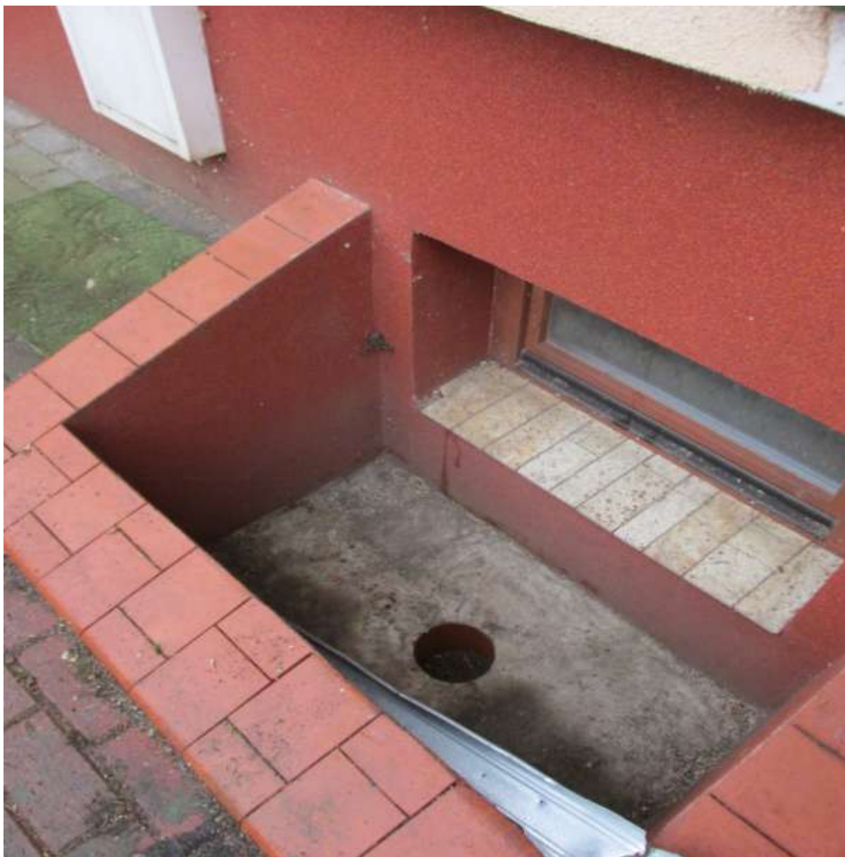
Ryc. 9. Grzebiuszka ziemna wspinająca się po ścianie studzienki doświetleniowej
