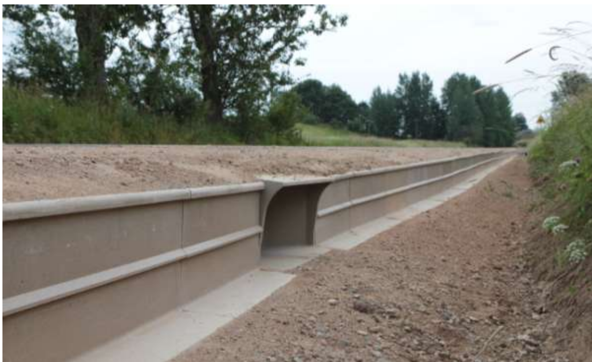
Fot. 1. System przepustów dla pólazów w miejscowości Skajzgiry (I)
