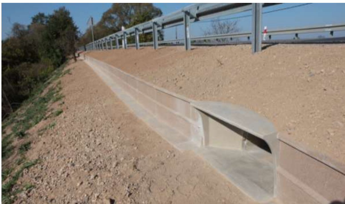
Fot. 5. System przepustów dla płazów w miejscowości Baciuty
