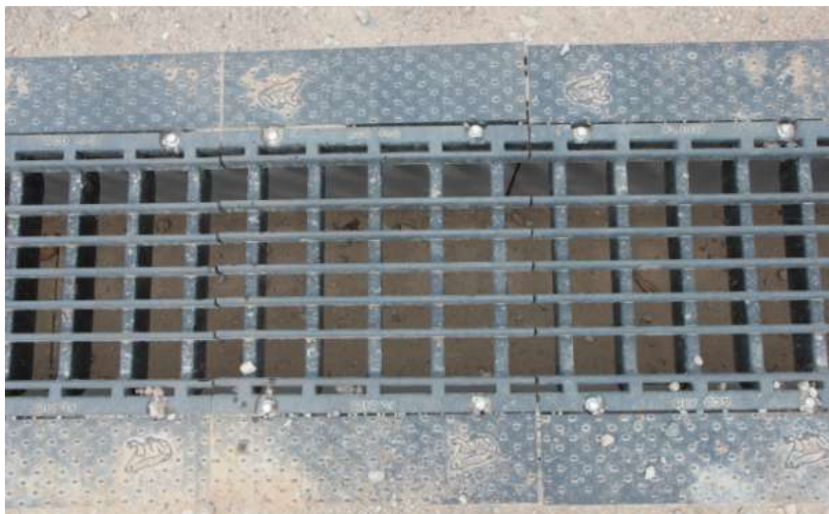
Fot. 8. Stopryna wbudowana w system przepustów w miejscowości Skajzgirya (I)
