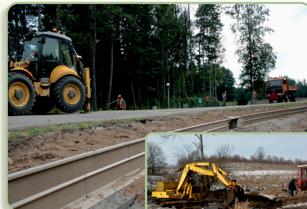
Budowa przejść dla płazów Building of passages for amphibians
