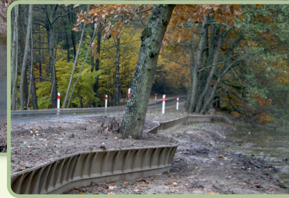
Przejścia dla płazów pod drogami Passages for amphibians under roads
